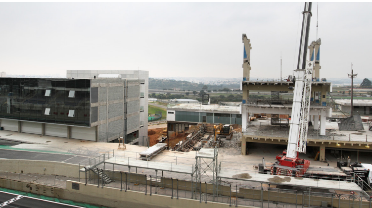
OBRAS NO AUTÓDROMO 2016 Adequação das garagens dos boxes. Imagem de 22/6.
